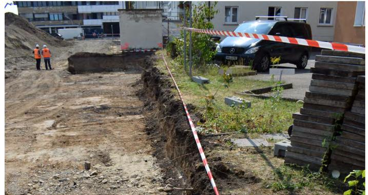
Untersuchungsfläche mit sehr dicht gelagerten Kiesen
