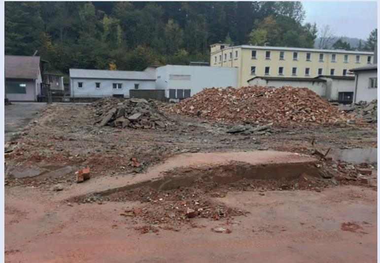
Ein stark ölverunreinigtes Werkstattgebäude wurde abgebrochen und das Material zur Beprobung in Haufwerke unterschiedlicher Belastung separiert
