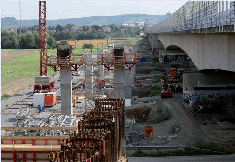
Herstellung der Hilfspfeiler für die Seitenlage, Urheber: ViA6West
