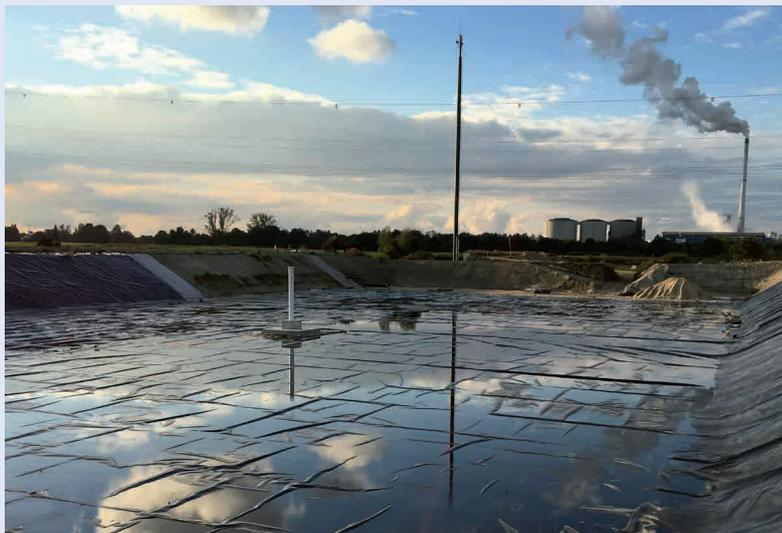
Verlegung der Kunststoffdichtungsbahnen gemäß Baufortschritt im Oxidationsteich Nr. 5
