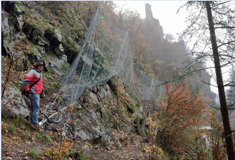
Steinschlagzaun (Energieaufnahme 1.000 kJ, Bauhöhe 4 m) nach Fertigstellung
