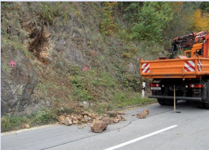
Wiederholt auftretenden Ausbrüchen kleinerer Einzelfelsen in Straßennähe kann durch Beräumungen vorgebeugt werden. Eine größere Sicherheit bieten technische Lösungen.
