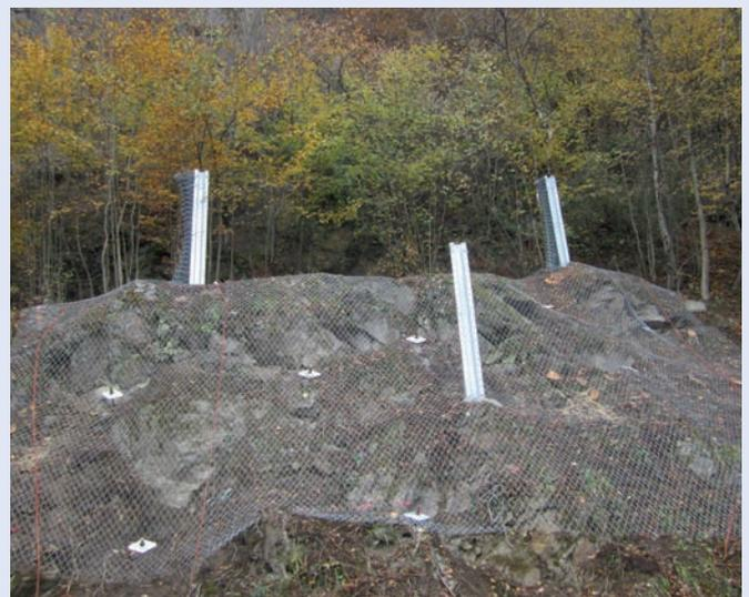
Stark strukturierte Hangbereiche werden mit einer Kombination aus Steinschlagzäunen und aktiven Böschungsstabilisierungssystemen (Sicherungsnetze) gesichert.
